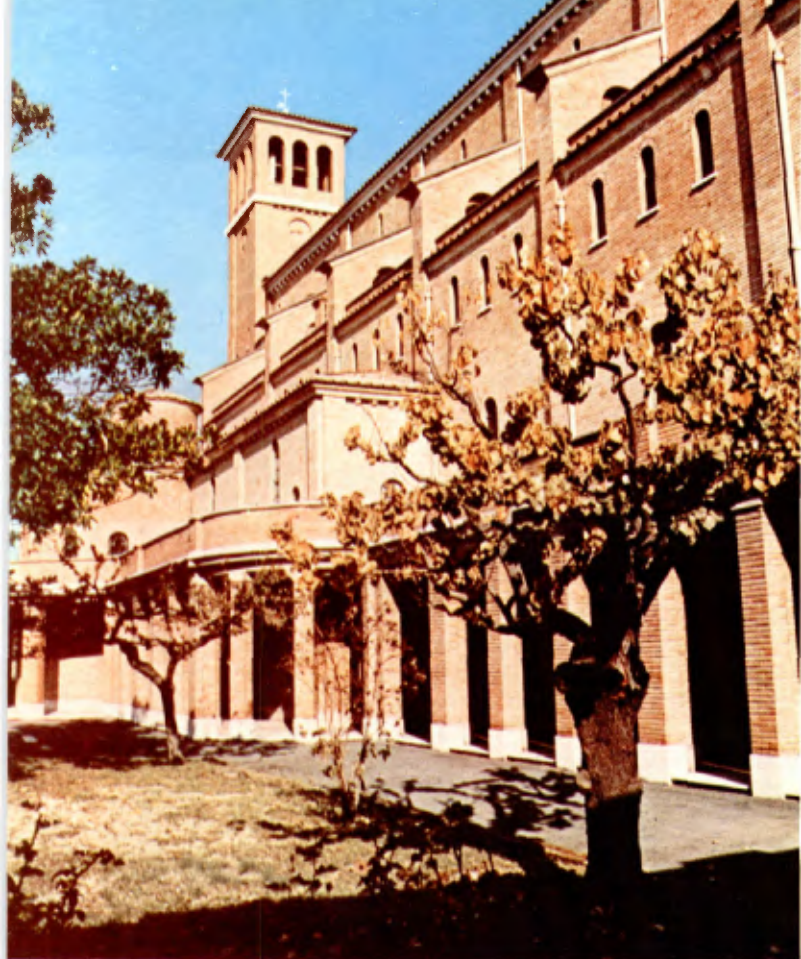
Vista lateral del Santuario de San J. Bta de La Salle en la Casa Generalicia.
