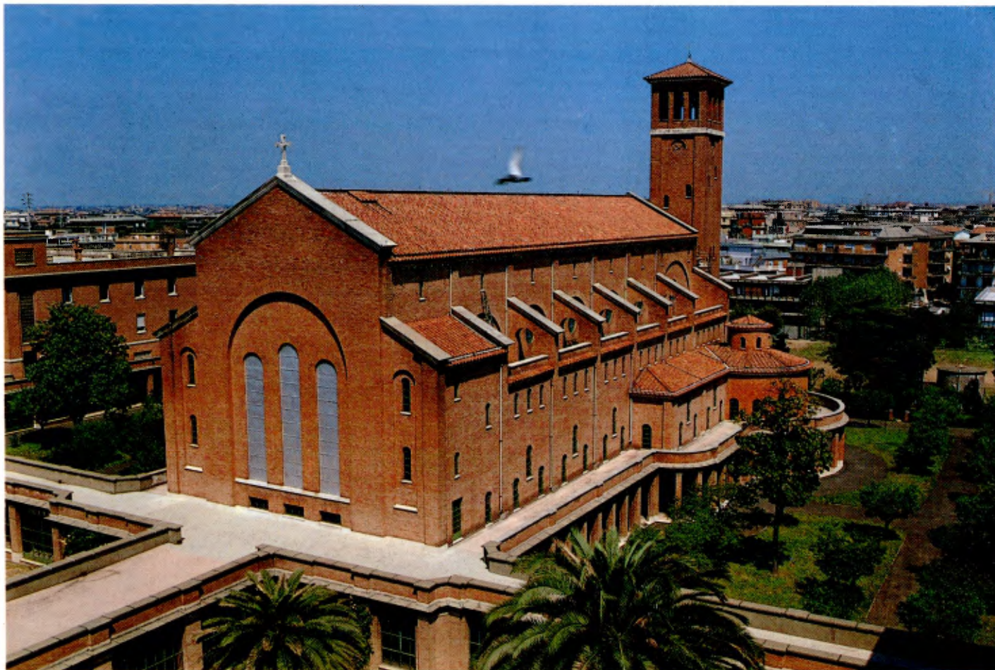
Santuario dedicado a San Juan Bautista de La Salle, en el centro de los edificios que constituyen la Casa generalicia.
