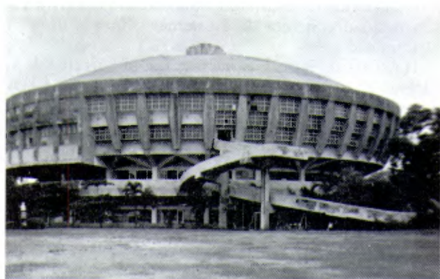
Edificio San Benildo, de La Salle Green Hills, sede de importantes encuentros lasalianos del Distrito de Filipinas.
