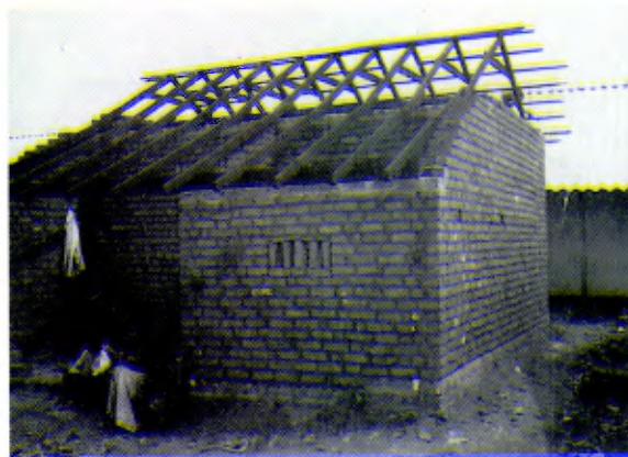
Ciudad de los Muchachos San José. Una nueva casa, recién construida, esperando el tejado.
