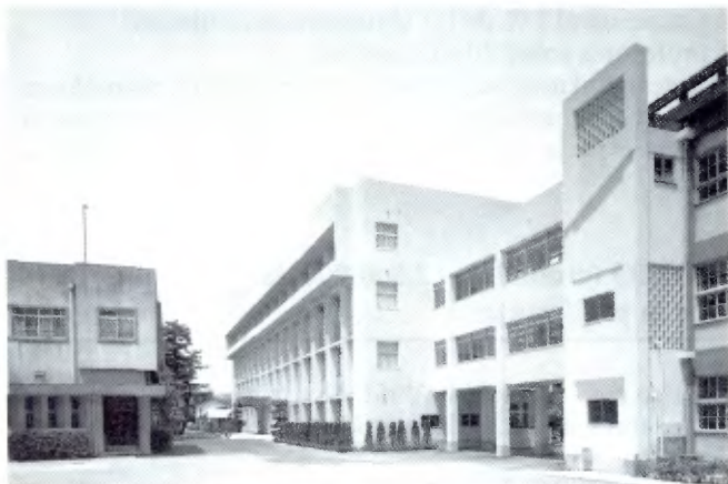
Kagoshima: a la derecha, edificio central; a la izquierda, en la planta baja, la capilla; y en el piso, habitaciones de los Hermanos.
