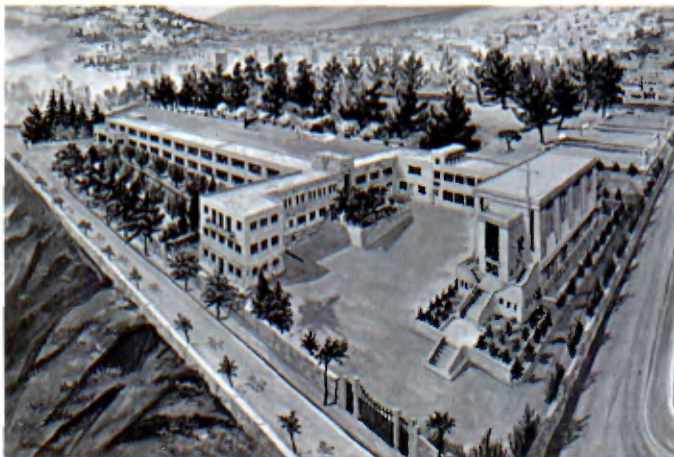
Amman: vue d'ensemble du Collège La Salle.
