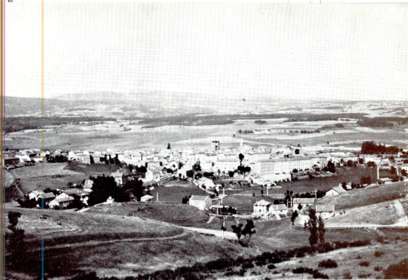
Saugues, vue générale
