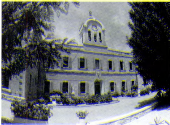
Universidad de Belén: parte antigua del edificio.
